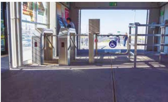
Las garitas de cortesía deben permitir el fácil desplazamiento al andén de la estación y contar con un ancho mínimo de un metro.
