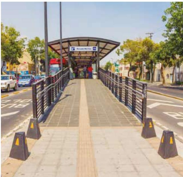
La línea 5 del Metrobús es un ejemplo de una correcta ejecución de rampas. Su diseño permite que la ruta accesible tenga una fácil conexión con el entorno urbano, así como al acceso a las estaciones.
