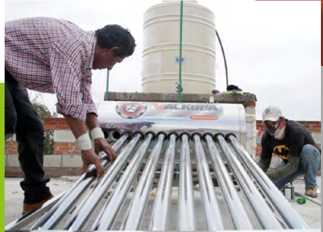
Instalación de calentadores solares en los municipios del estado de Puebla. Imagen del Gobierno del estado de Puebla
